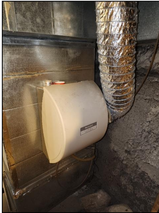
28. Trickle/cascade type humidifier
