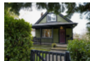
219 E. Queens Rd
